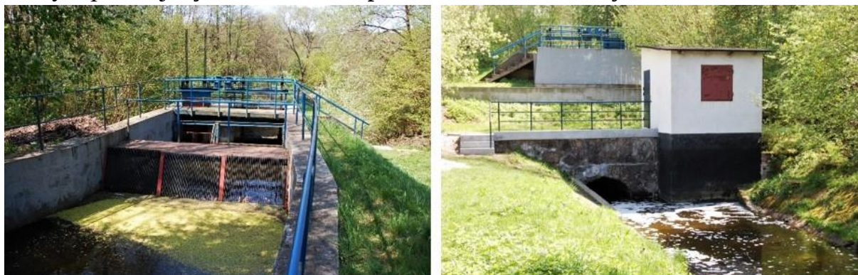
Jaz i budynek elektrowni obecnie. Fot. autora.
